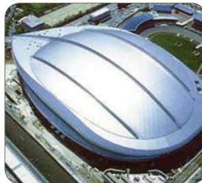
SUS445J2, Kitakyushu Mediadome (Fukuoka Pref.) 1998, Japan
