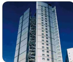
SUS445J1 und SUS445J2, Nakano-Sakaue-Gebäude, 1996, Japan
