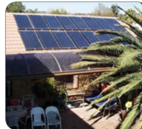
Solarpaneele: Rahmen und Kollektor sind potenzielle Anwendungen für die Ferrite 1.4509 (441) und 1.4521 (444)
