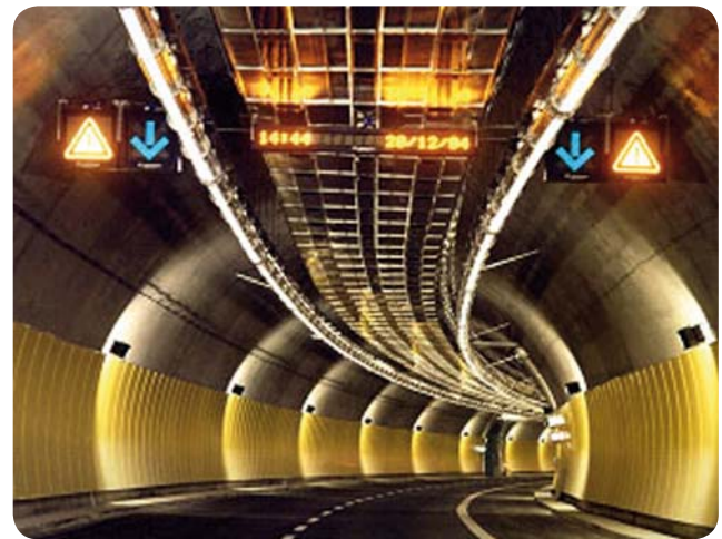
Verkleidungsbleche aus beschichtetem 1.4016 (430), Italien.
