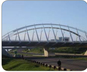
1.4003 (410), lackiert, SASSDA, Südafrika [Brücke seit mehr als 8 Jahren in Nutzung]
