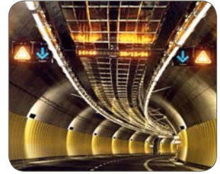
1.4016 (430), lackiert, Monte Mario-Tunnel, Centro Inox, Italien
