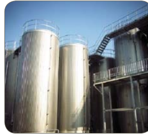
SUS430J1L (1.4016/430), farbig kunstharzbeschichtete Außenverkleidung, JSSA, Japan
